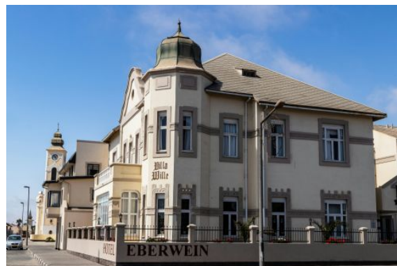
Edificio colonial, Swakopmund
